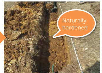
④ Backfill
